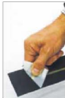
Рис. 16 Устранение защитной пленки CARBOPLATE
